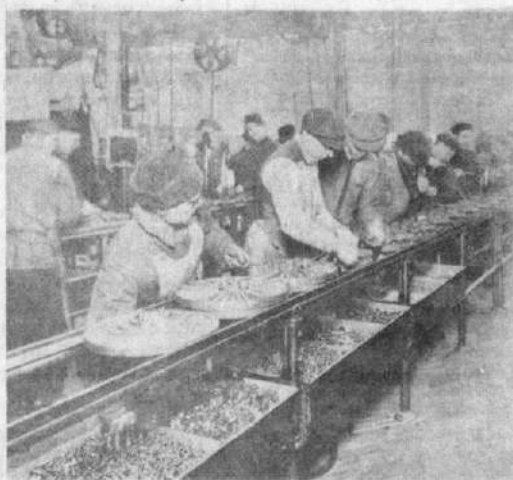
A revolucionária linha de montagem lançada pela Ford, com as peças iam na mão dos montadores.
